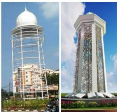
Gambar 6. Ide perencanaan pengembangan tugu Pamulang yang tidak sesuai dengan perencanaannya. Ide landmark berupa tugu Pamulang tidak direncanakan matang karena bentuknya besar sehingga tidak sesuai dengan lingkungan yang sempit.
