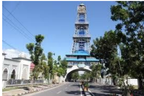
Gambar 4. Bentuk menara Pakaya, Gorontalo. Bentuknya menyerupai menara Eiffel, Paris, Perancis. Menara ini bentuknya tidak memiliki ciri yang khas karena mengadopsi dari bentuk tanda dari tempat lain. Sebagai landmark kota kurang baik. Sumber; Kompasiana
